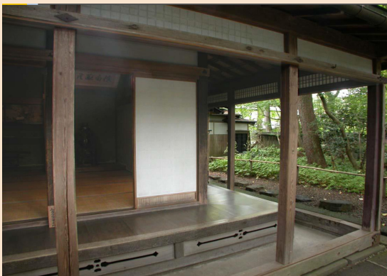
伝統木造が話題になっている。ひさしがあると光の入りが変わり暗くなる。光沢性のある床材を設置した縁側を設けることによって、室奥まで光を導入する。単に熱の出入りだけでなく、自然光も関係するところは、まだ省エネ基準では十分できていない。伝統に学ぶところは多いと思う。
