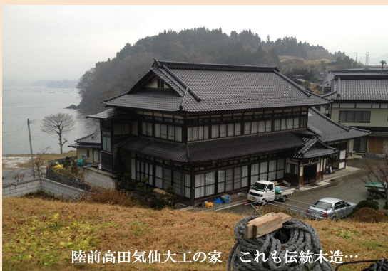
伝統木造が話題になっている。ひさしがあると光の入りが変わり暗くなる。光沢性のある床材を設置した縁側を設けることによって、室奥まで光を導入する。単に熱の出入りだけでなく、自然光も関係するところは、まだ省エネ基準では十分できていない。伝統に学ぶところは多いと思う。
