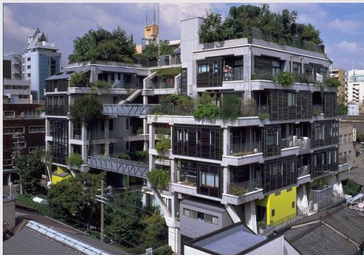
大阪ガス実験集合住宅NEXT21は、将来の集合住宅のあり方を社内外の皆さまとともに考え、検証する場として建設された。地下1階、地上6階建て、18戸の集合住宅。竣工'93年
