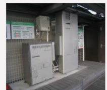
NEXT21でのSOFC設置状況
